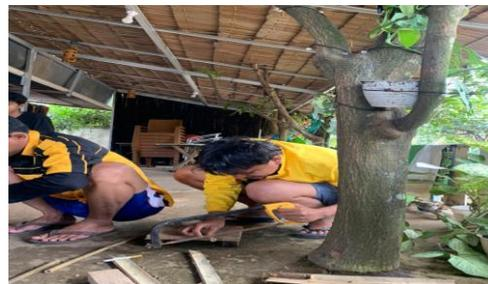
**Gambar 3. Melubangi Bagian Tengah Bambu**
